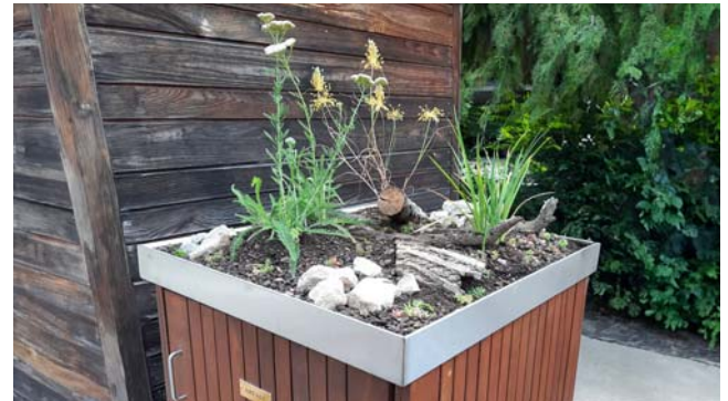
Mülltonnenbox mit Elementen eines Biodiversitätsgründachs.
